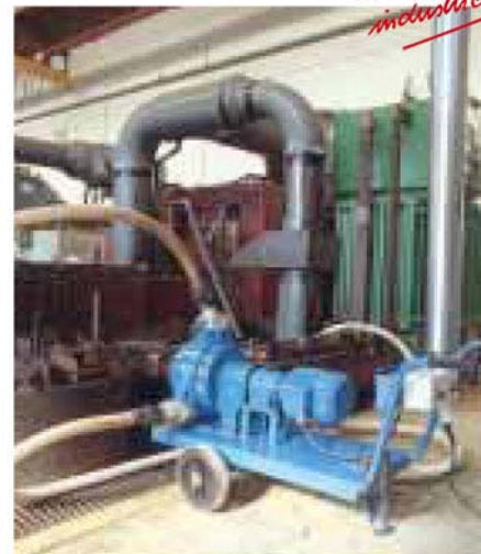
Pompe Z en vidange de puisards
